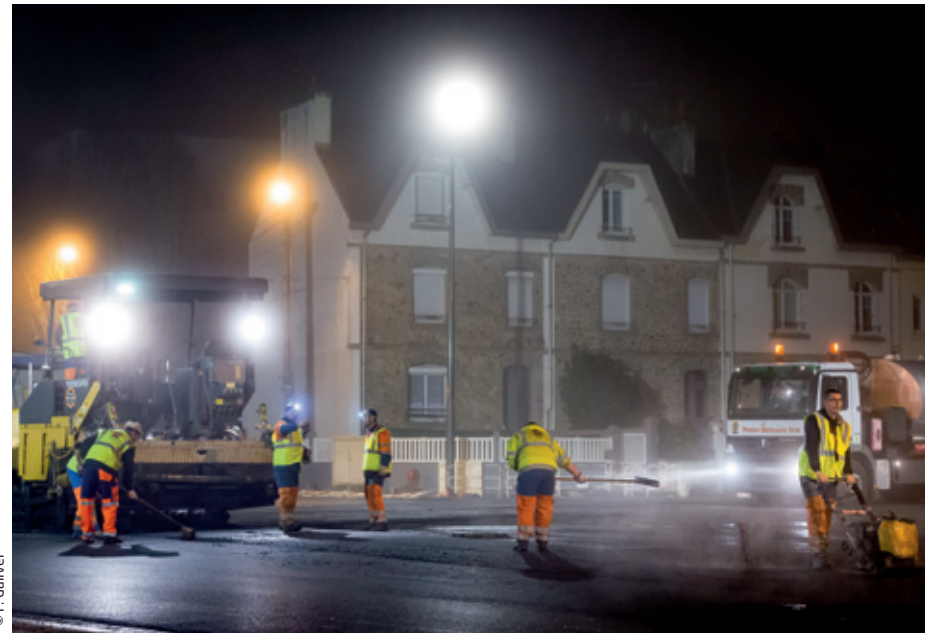
Travaux de la nuit du 9 mars sur le carrefour de Kerjulaude à Lorient
